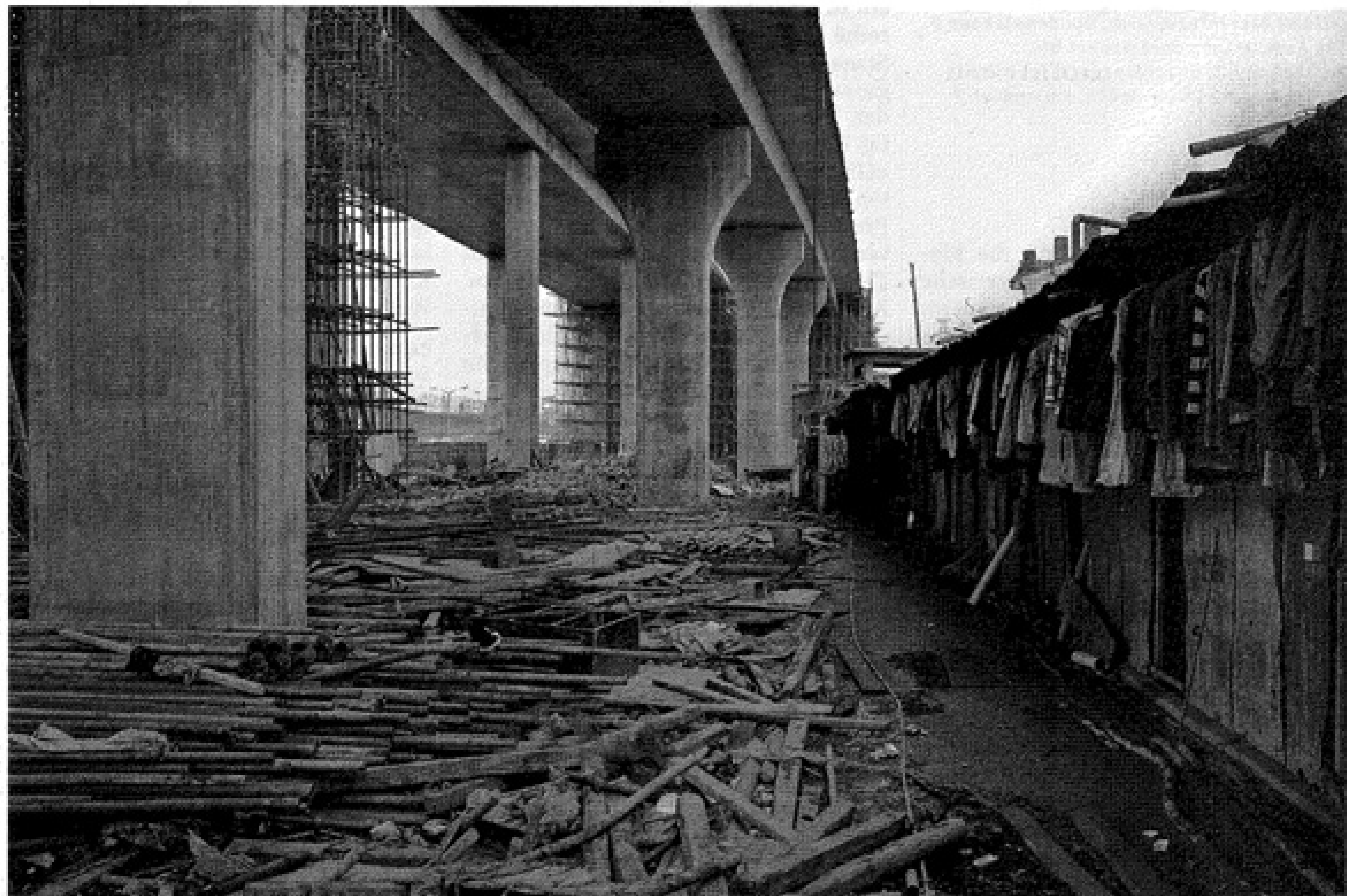
Unterkunft von Wanderarbeitern: Auf einer Autobahnbaustelle im Norden der Stadt Guangzhou. Februar 2005.
